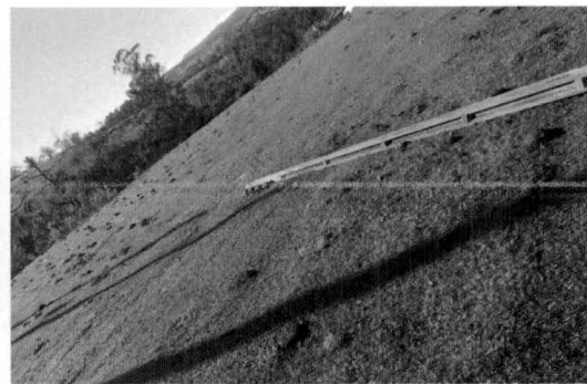
Queda de rede elétrica na área rural
